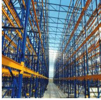
Resim 1.8: Giydirme raf sistemleri
