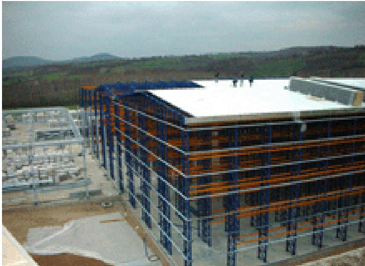
Resim 2.11: Giydirme - yüksek kayar raf sistemi yapımı
