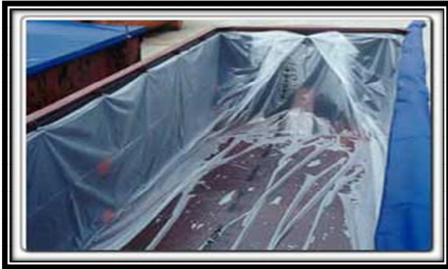
Resim 2.50: Konteyner zeminine naylon türü destekleyici malzeme serilmesi
