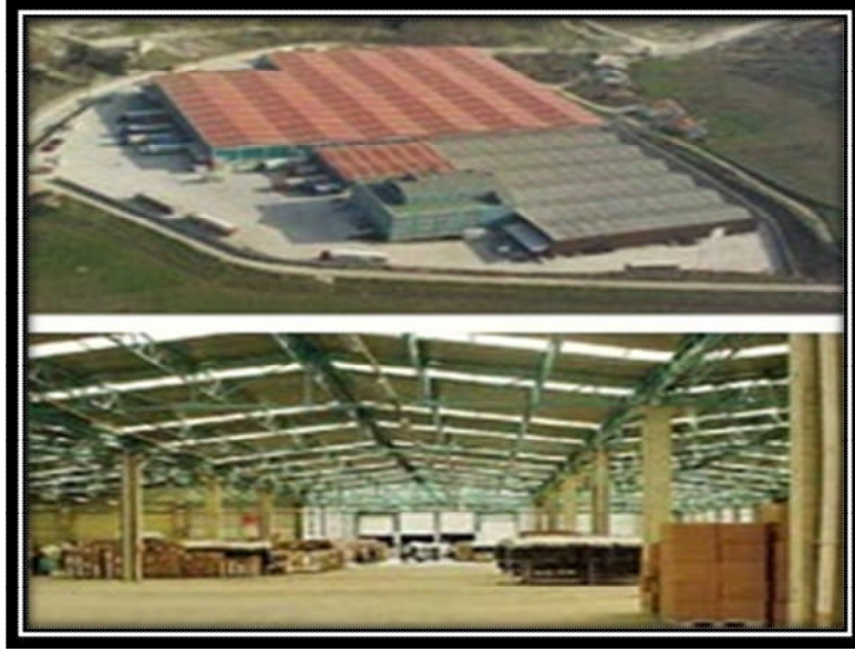
Resim 1.6: Depo - antrepo iç ve dış görünümü
